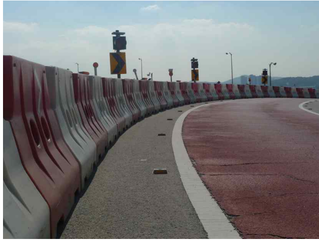
<그림 13> PE 울타리 설치 예
