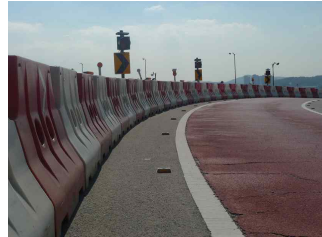
<그림 13> PE 울타리 설치 예
